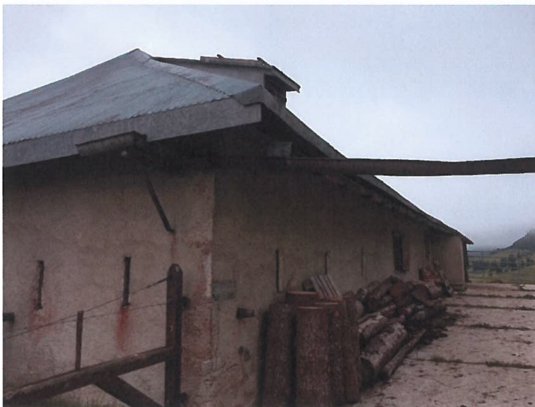
Façade Nord - Est
