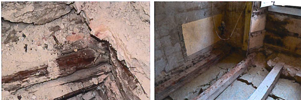
Poutraison de la cuisine
