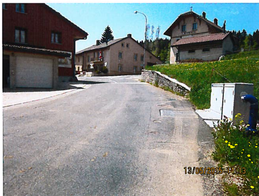
Etat général de la chaussée
