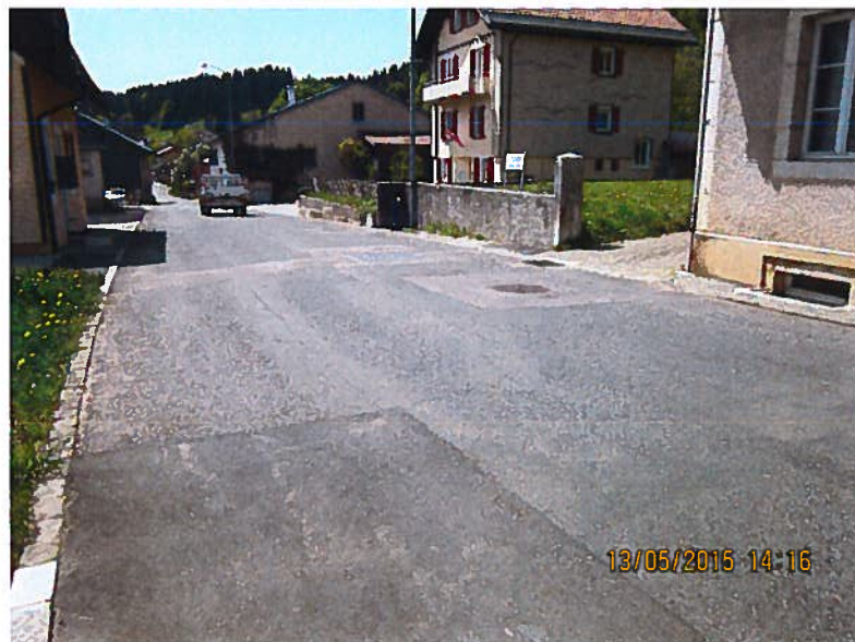
Etat général de la chaussée
