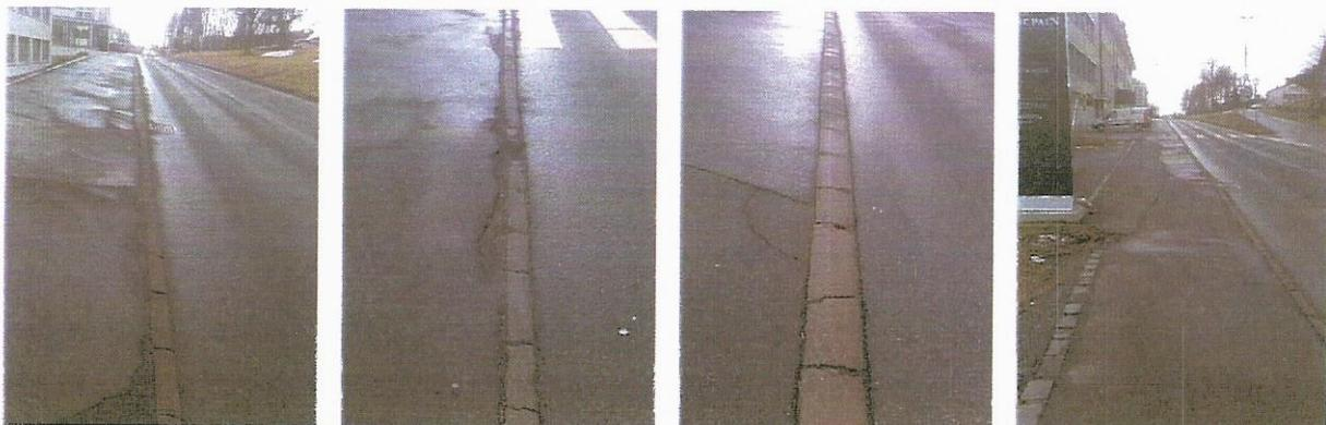
Figure 1 - Exemples de dégradations du trottoir
