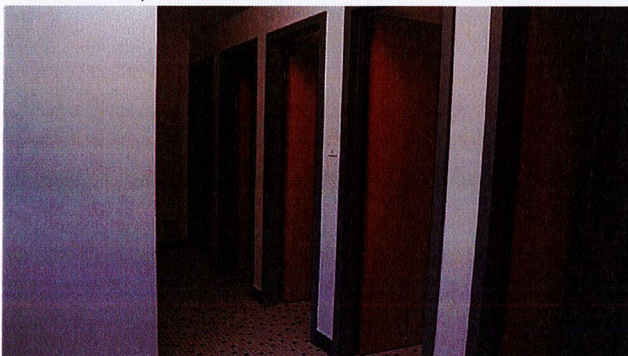
Sanitaires, conservés en l'état
