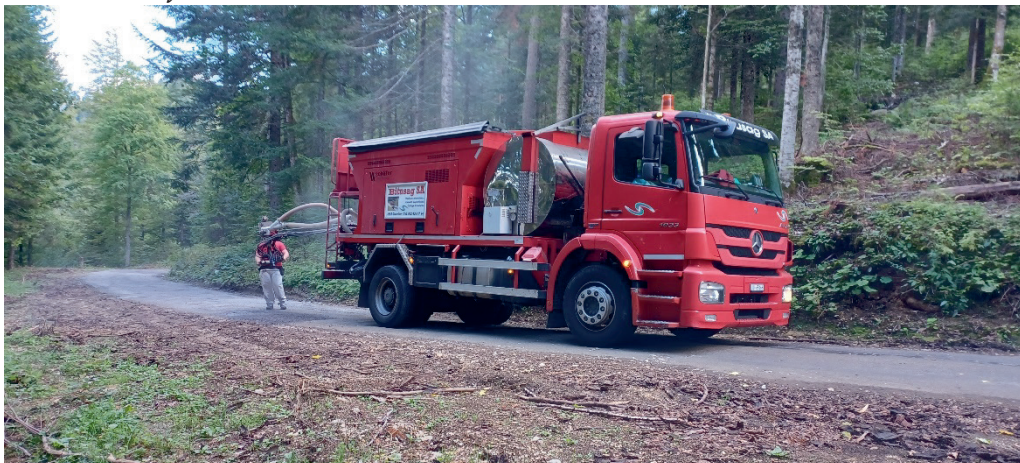
Photo 2 – Réfection sur le chemin du Biblanc
