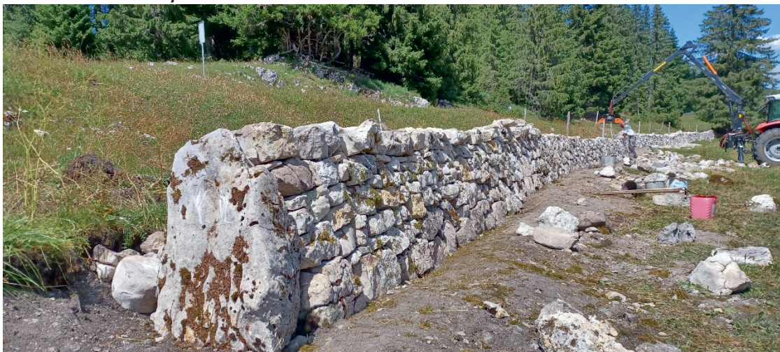
Photo 3 – Mur en pierres sèches Les Grandes Roches
