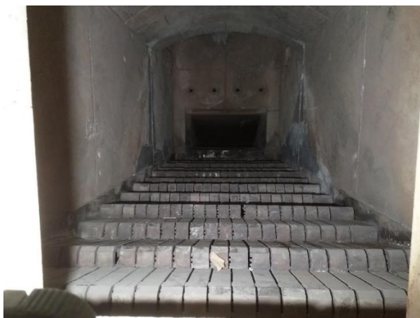
Foyer de la chaudière rénové
