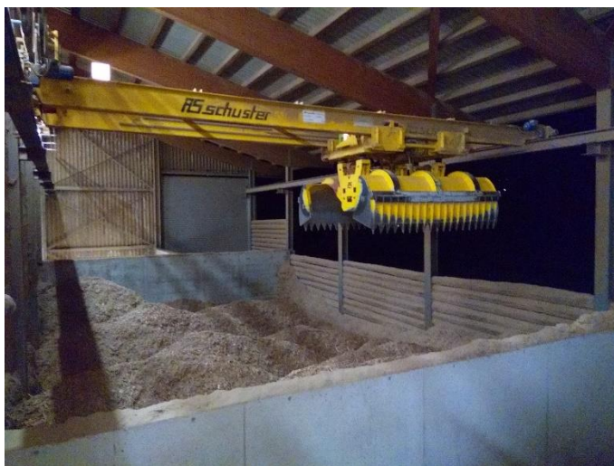
Stockage intermédiaire (~800 m 3 )
