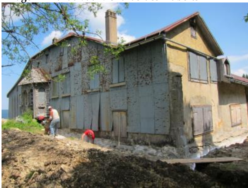
Image 2- Travaux au Mollards-des-Auberts
