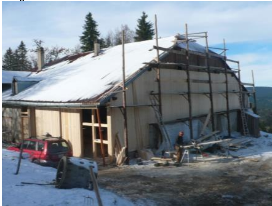
Image 3- Travaux hivernaux au Mollards-des-Auberts
