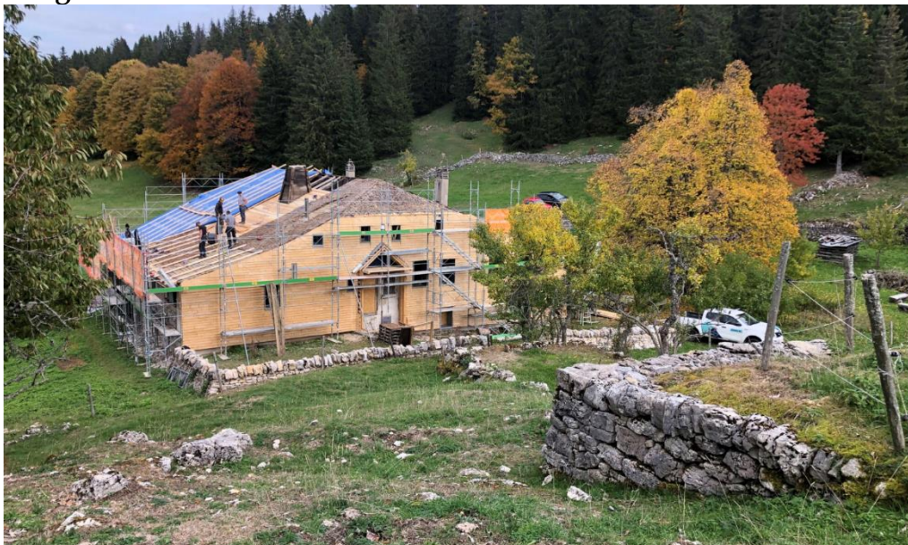
Image 4- Travaux au niveau de la toiture
