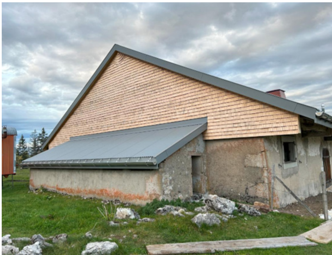
Photo 6 – Chalet du Crotton façade sud-est
