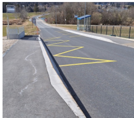
Photo 7 - Zone d'arrêts de bus
