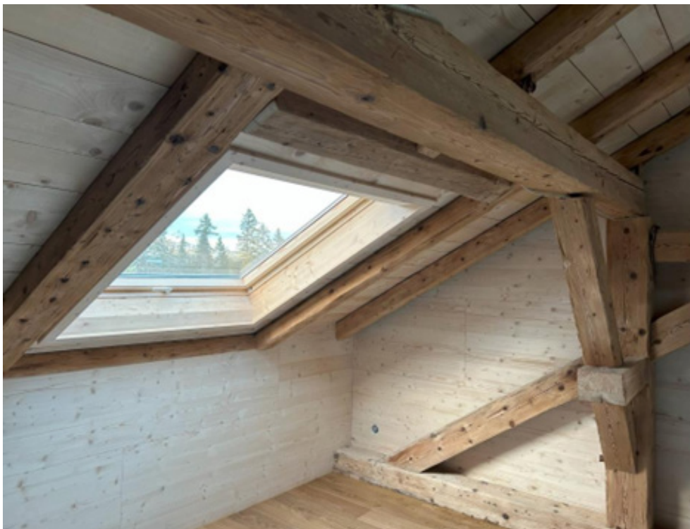
Photo 8 - Aménagement d'un grand Vélux à l'étage
