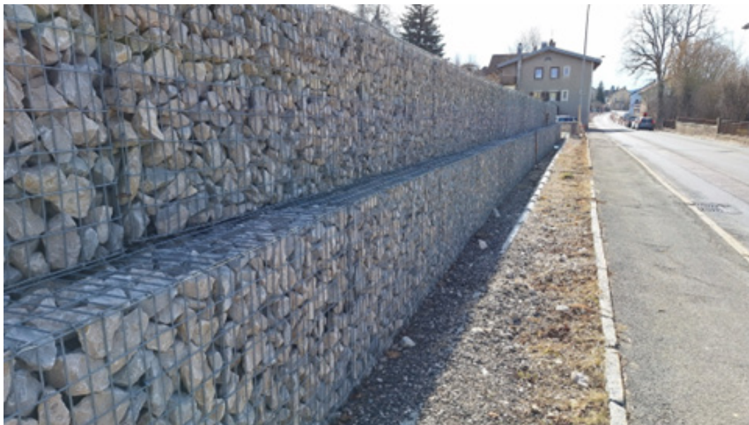
Photo 13 – Mur de cailloux, chantier
