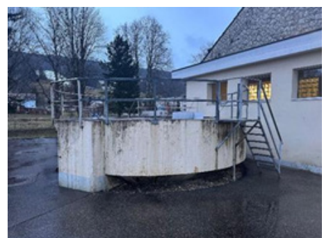
Photo 6 - Épaississeur des boues
