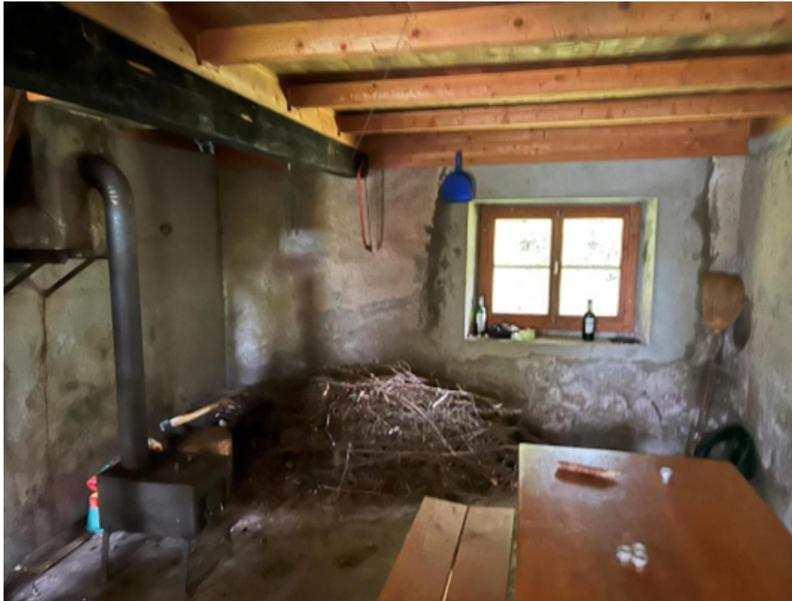
Photo 5 – Chalet de la Croix du Vuarne (intérieur)
