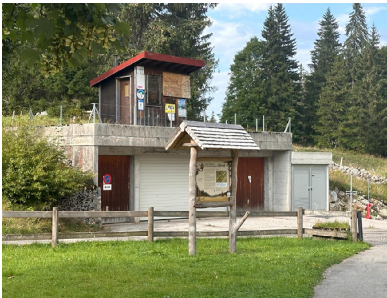
Photo 6 – Les garages qui restent après la démolition
