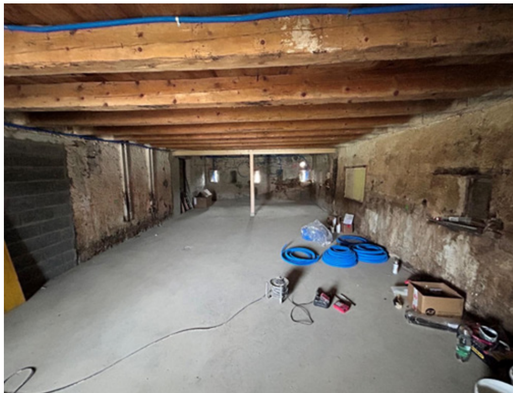
Photo 2 – Etat des travaux le 3 décembre 2024
