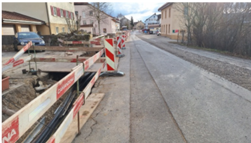
Photo 11 – Travaux, Rue Centrale
