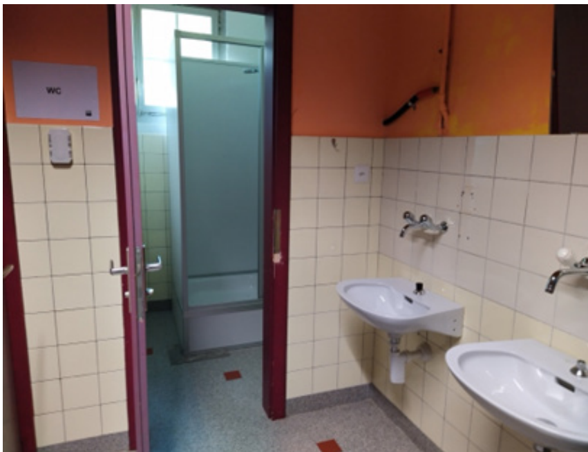
Photo 4 – Les WC mis à disposition par la Commune et le Centre Nordique Vallée de Joux
