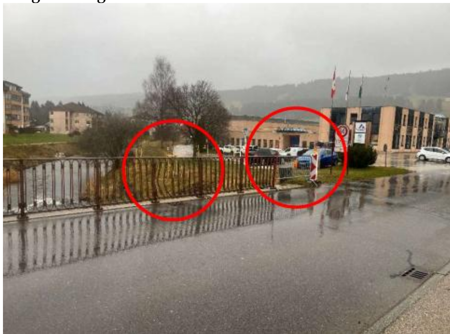
Image 6 – Dégâts à la suite de l'accident
