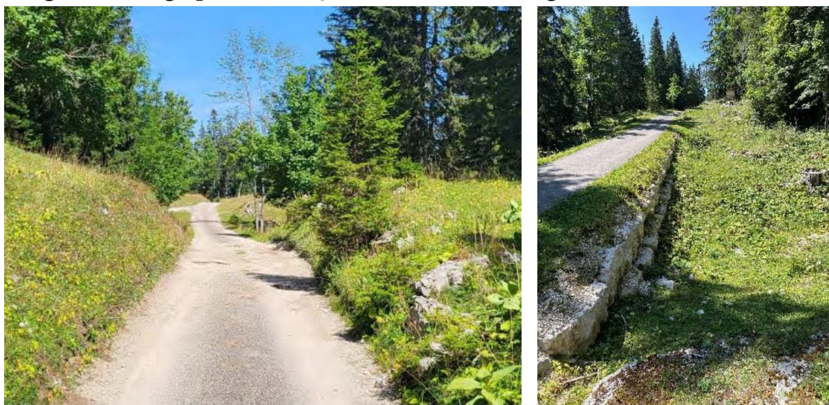
Image 2 – Photographie de tronçons du chemin des Bégnines
