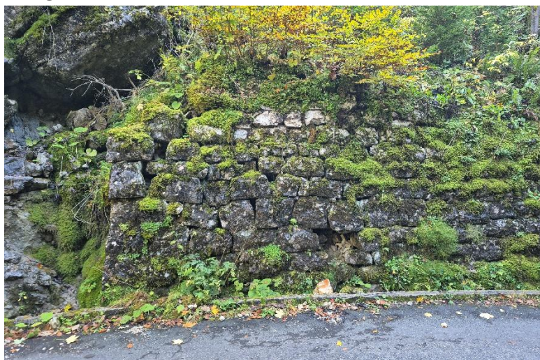
Image 6 – Mur de soutènement en moellons
