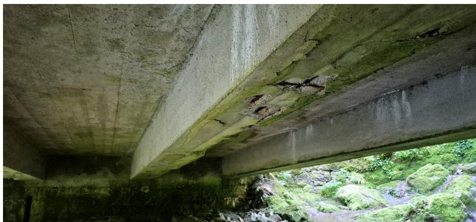
Image 5 – Photographie du tablier du pont amont sur le ruisseau du Biblanc
