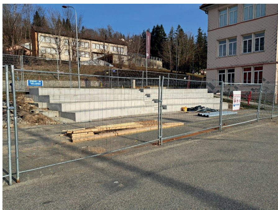
Image 43 : L'amphithéâtre en travaux
