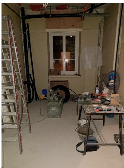
Image 44 : La future cuisine, encore en travaux
